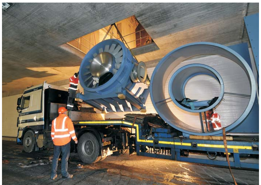
Installation der Abluftventilatoren in der Lüftungszentrale West.
