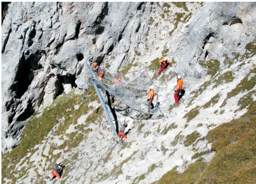
Aufwendige Montage der Schneenetze im steilen Anrissgebiet am Geisshorn.
