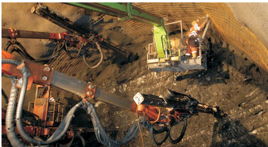
Steigender Sprengvortrieb vom Portal West aus.
