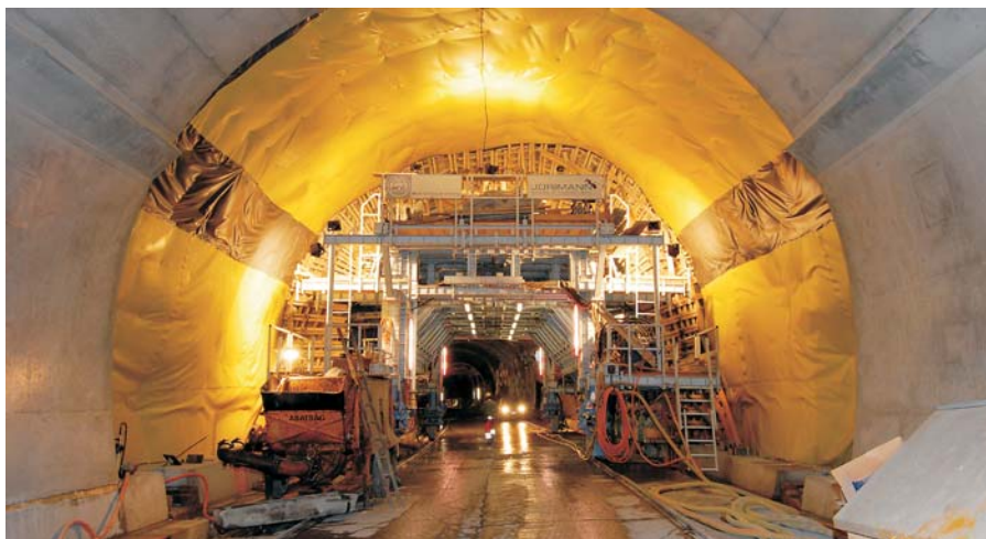
Alternierendes Betonieren des Innenringes in 10-Meter-Etappen.
