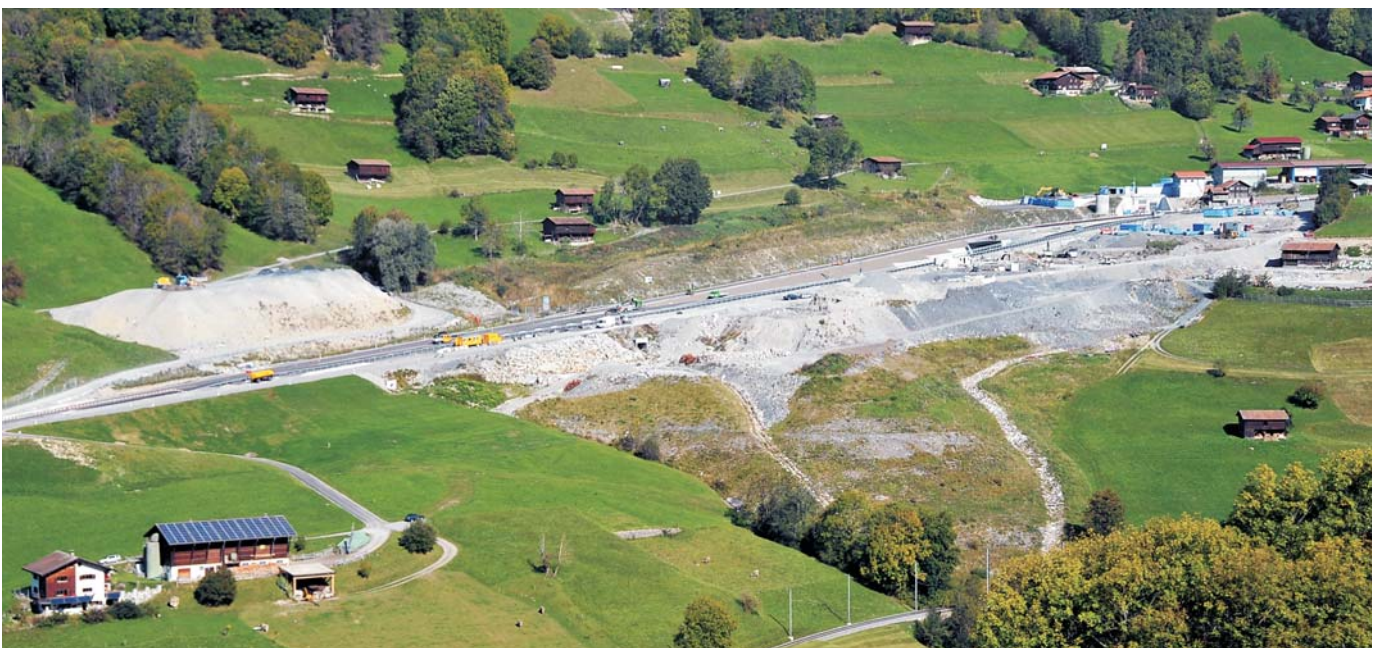
Die grossflächigen Schüttungen wie hier beim Westportal des Saasertunnels sind so angelegt, dass sie als landwirtschaftliche Flächen benutzt werden können.
