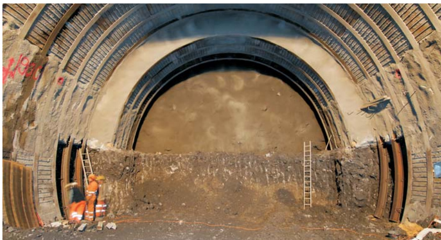
Fallender Vortrieb im Lockermaterial mit Stahleinbau vom Portal Ost aus.
